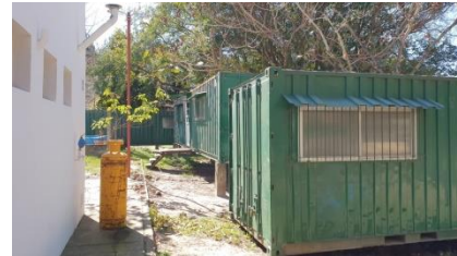
- sanitäre Anlagen (links) und Container-
